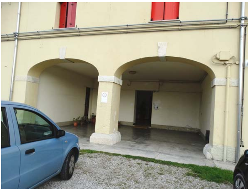
IL PORTICO D'INGRESSO
